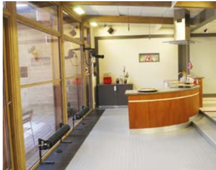
Placerade vid fönster motverkar kamrörsradiatorerna effektivt det kallras som ofta bildas vid stora glasytor.
