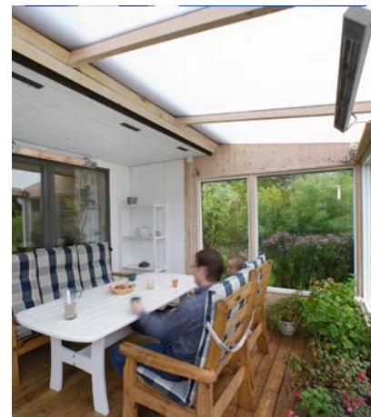
CIR är lättplacerad tack vare sin utformning. För jämn uppvärmning bör infrorna värma från minst två håll.
