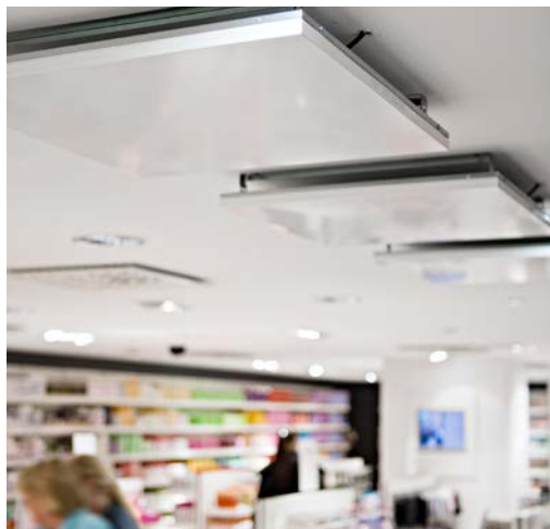
Takmontering skyddar Thermocassette från åverkan.
