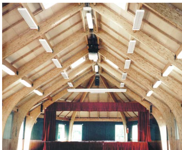
EZ200 värmer direkt efter påslag och ingen förvärmning behövs, vilket gör den idealisk för byggnader som används oregelbundet.
